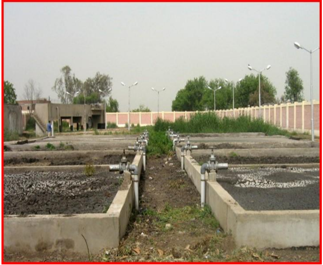
صورة رقم ٤ توضح أحواض التجفيف الطبيعي
