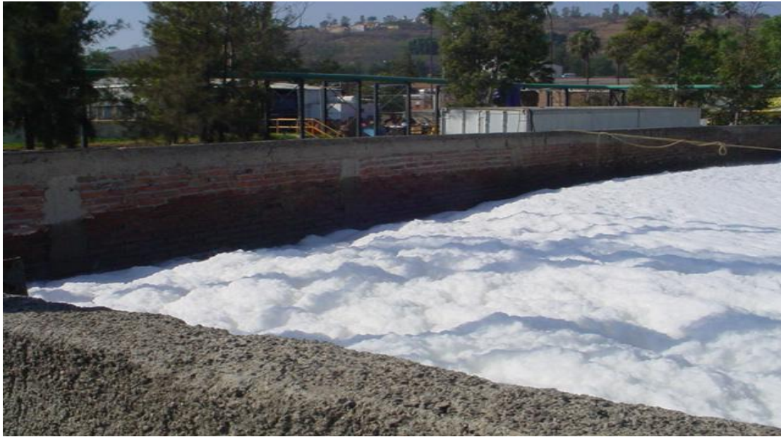
شكل رقم (١-٥) وجود رغاوى بيضاء بأحواض التهويه في بدايه التشغيل
